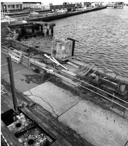
きれいに撤去された大間フェリーの痕跡
